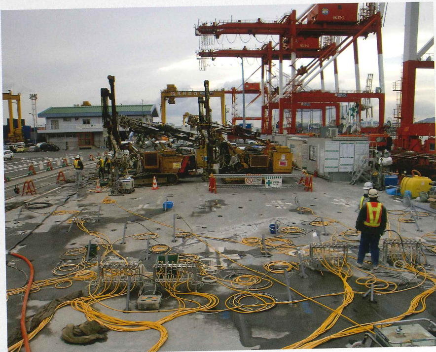
港湾での液状化対策のための薬液注入。液状化対策は河川や空港でも行われる
