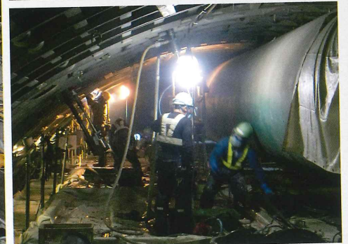
首都高速中央環状線の新設工事。深度約50mで薬液を注入する作業
