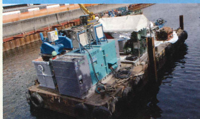
河川護岸下部の地盤強化工事 (東京都世田谷区)
