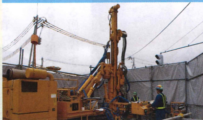
地下鉄敷設工事 (宮城県仙台市)
