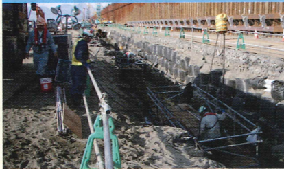
被災した高速道路の復旧工事 (神奈川県大磯市)
