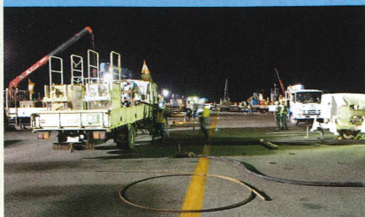
羽田空港の液状化対策工事 (東京都羽田空港)
